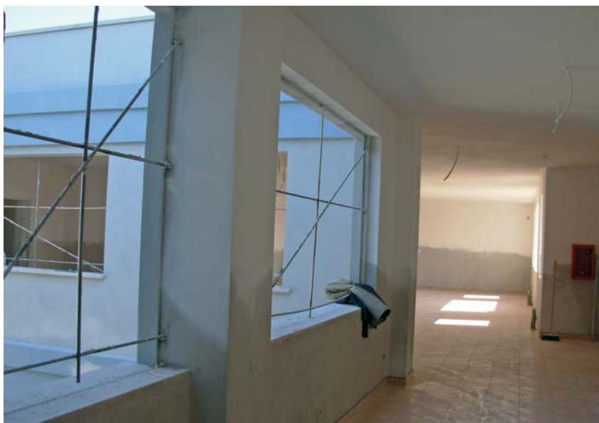
Il cantiere quasi concluso della nuova ala della Biblioteca e Ufficio cultura.
