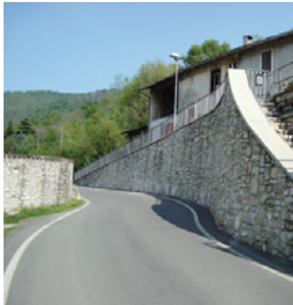
Il muro di via Cairoli
