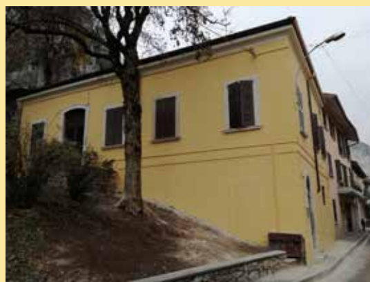
Rifatto il tetto e riqualificato l'edificio comunale in via Trieste a Virle
