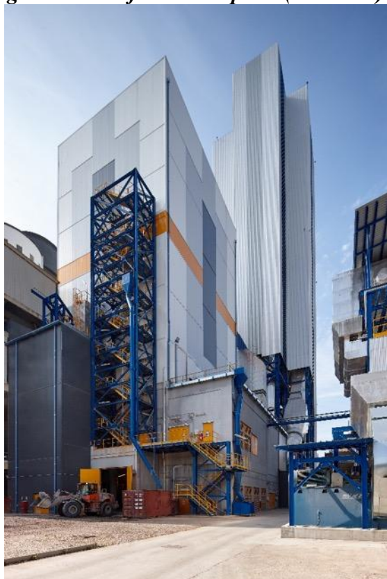
Figura 3.2- Edificio roller press (a sinistra) e torre di preriscaldamento e forno rotante (a destra)
