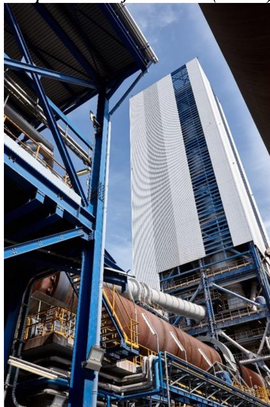
Figura 3.2- Edificio roller press (a sinistra) e torre di preriscaldamento e forno rotante (a destra)
