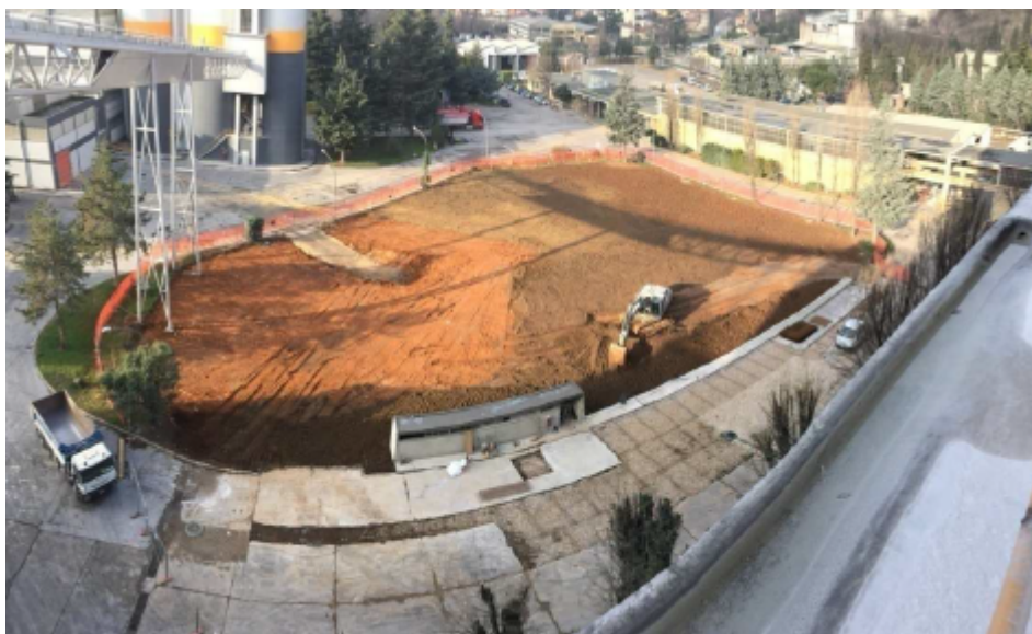
Figura 3.4- Ex deposito OCD a seguito della rimozione dei 5 serbatoi
