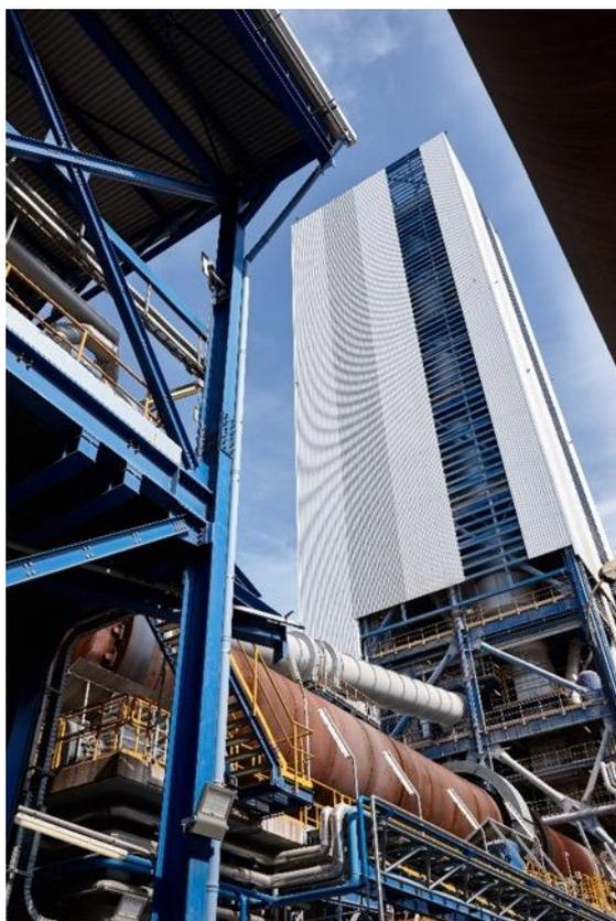
**Torre di preriscaldamento e forno rotante**
