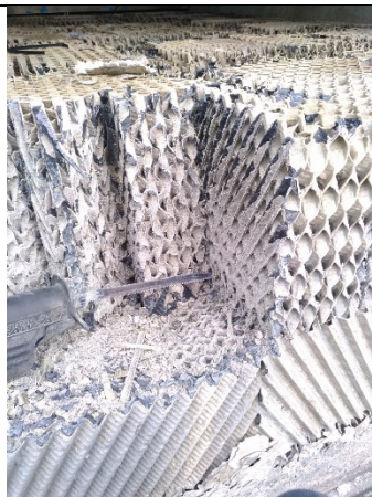
Figura 9: Interventi di demolizione
